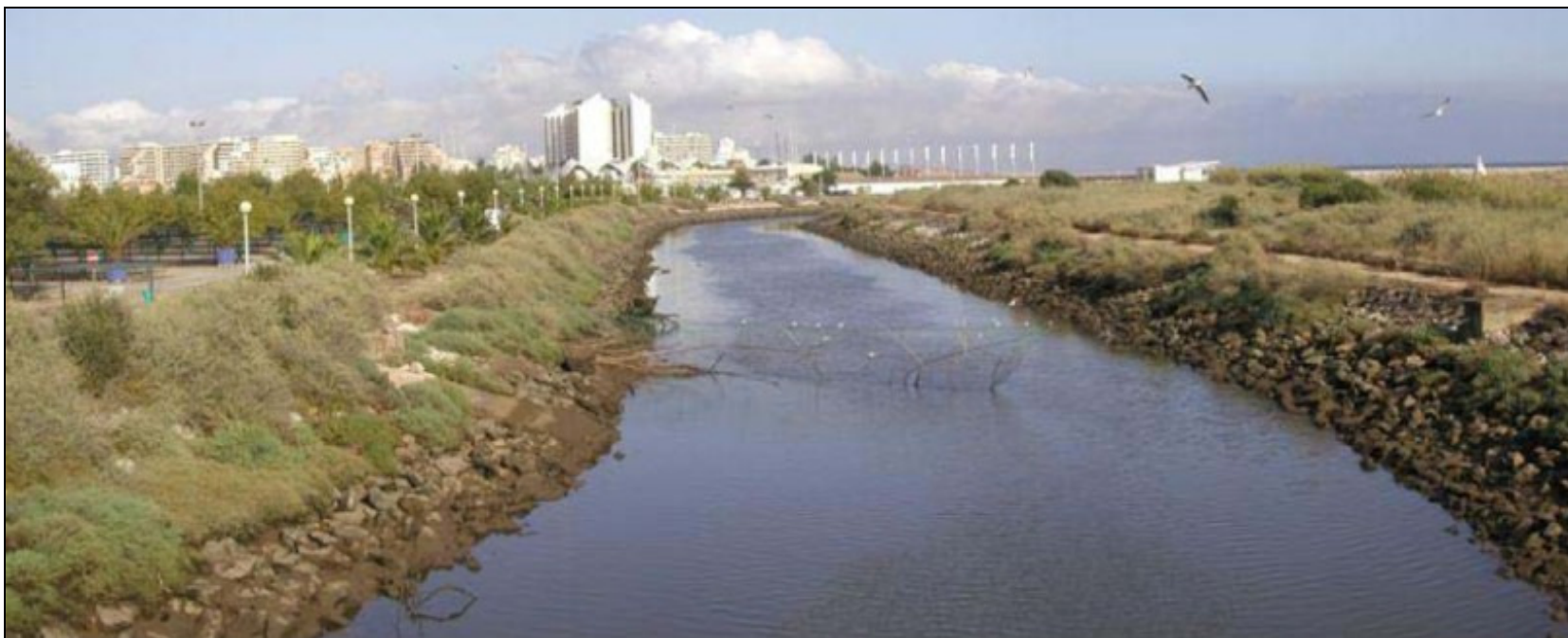
Figura 4.9.5 - Ribeira da Quarteira para jusante da ponte de acesso à praia da falésia. Neste troço a ribeira funciona como limite físico entre a zona Urbano-Turística e a Orla Litoral
